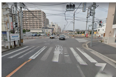
■上福岡駅前県道56号の拡幅工事
